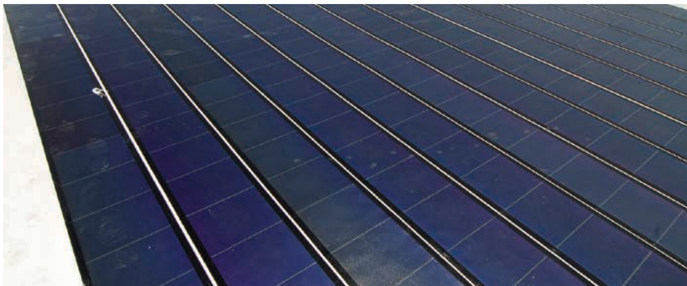
Fig 2 Film PV mince sur un toit
