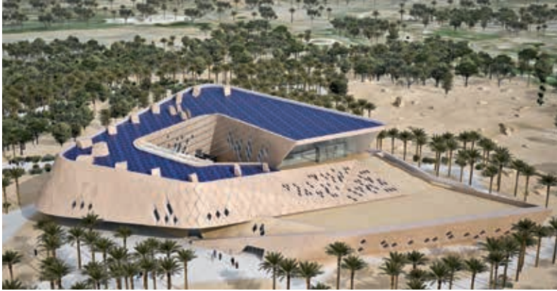
Fig 1 Centre éducatif en plein désert, Al Aïn - Abou Dhabi
