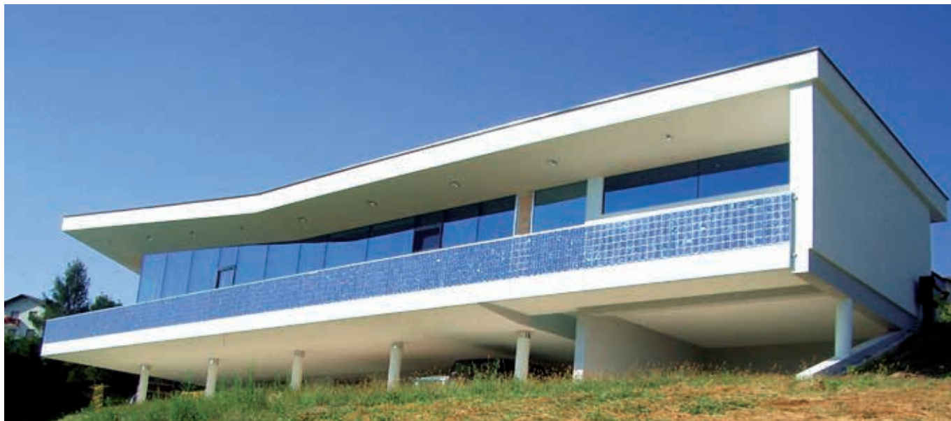
Fig 25 Maison sur la colline à Passail, Autriche
