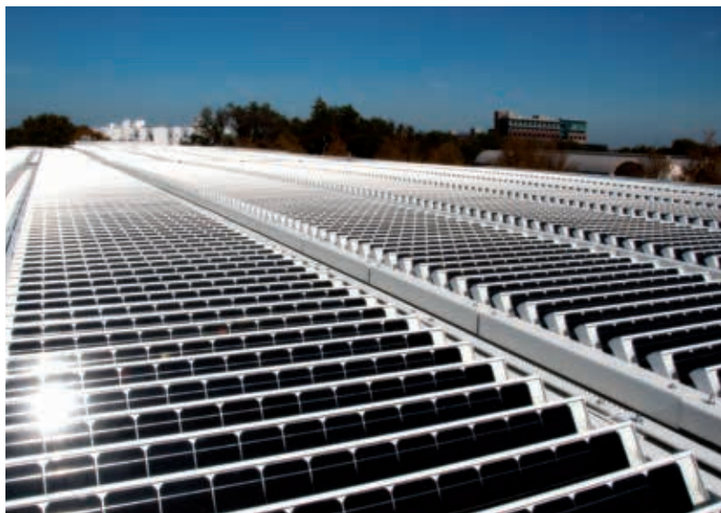
Fig 17 Nouveau pavillon du musée Kimbell, États-Unis, toit.
