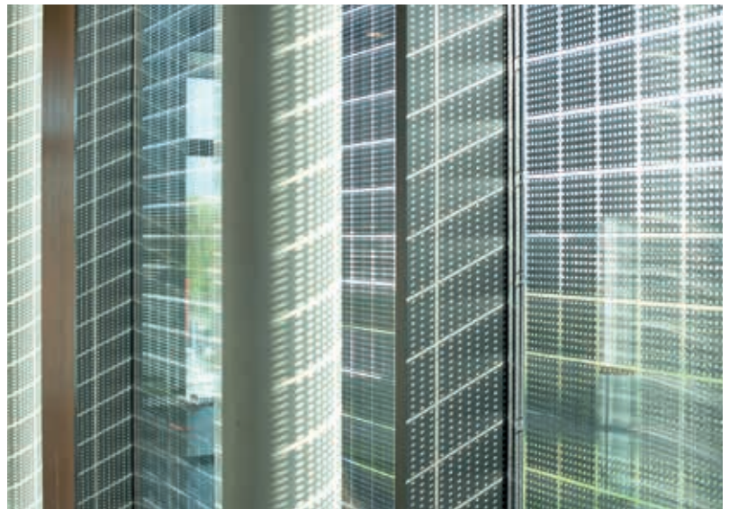
Fig 24 Stadtwerke Konstanz Energy Cube, Allemagne
