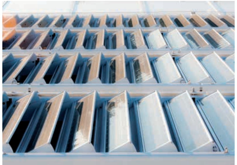
Fig 18, 19 Nouveau pavillon du musée Kimbell, États-Unis, toit.
