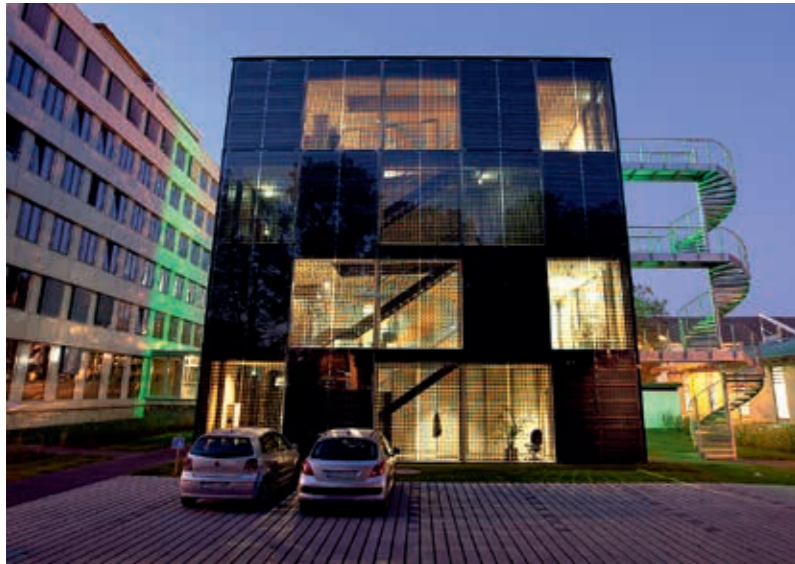
Fig 23 Stadtwerke Konstanz Energy Cube, Germany
