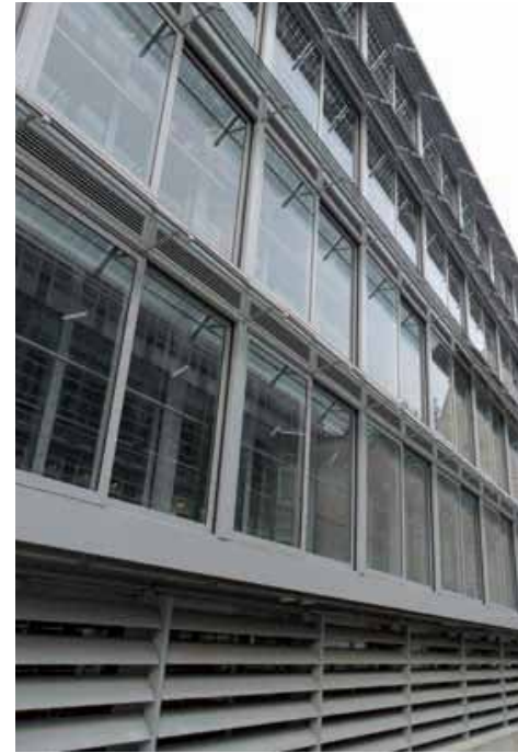
الشكل ٧ الخلايا الكهروضوئية القاطعة لمسار الشمس
