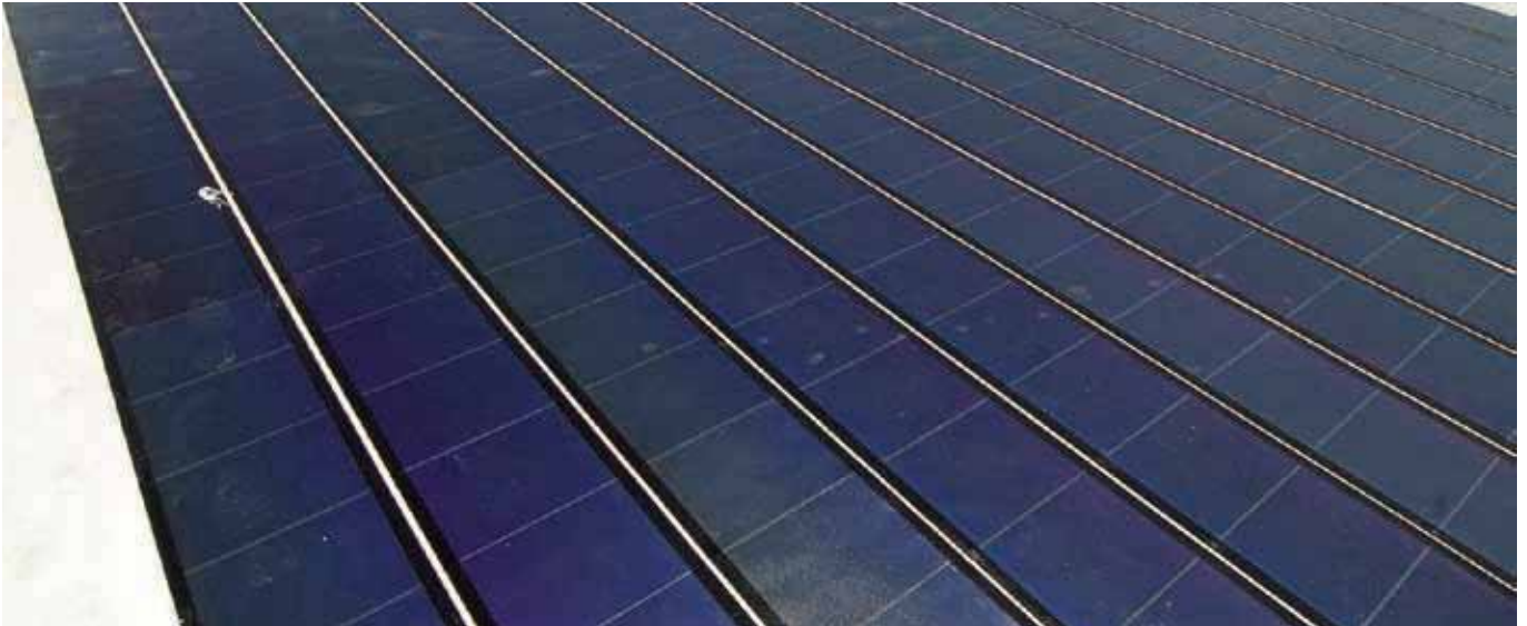
الشكل ٢ ألواح كهروضوئية من الأغشية الرقيقة مركبة على السطح
