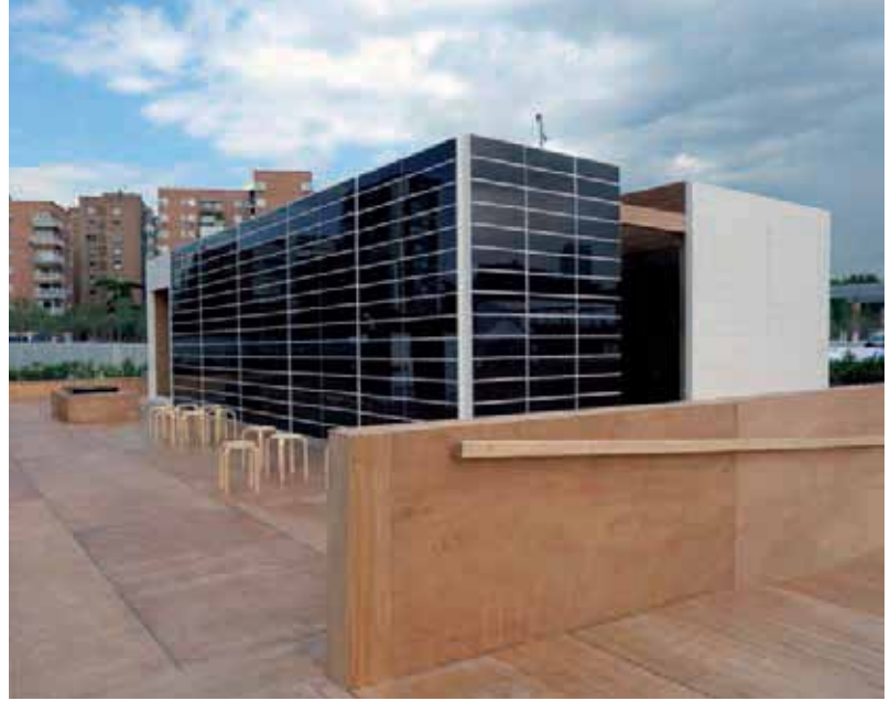
الشكل ٣ واجهة تهوية كهروضوئية. بنيت في مسابقة الطاقة الشمسية العشارية في أوروبا ٢٠١٠ (Solar Decathlon Europe 2010)
