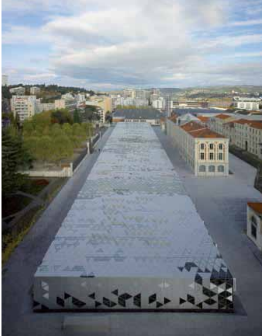
الشكل ٦ مدينة التصميم، منظر جوي للمبنى البلاتيني
